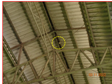
ภาพที่ 2.2-36 ระบบตรวจจับควัน (Smoke Detector) บริเวณพื้นที่ Ware House
