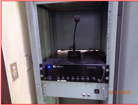
ภาพที่ 2.2-33 ระบบแจ้งเตือนเสียงตามสาย
